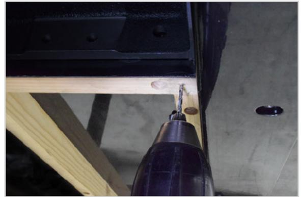
5. Schwenken Sie die Stützstrebenhalterung und die daran befestigten Teile wieder nach oben und richten Sie die Öffnung in der Halterung des Stützbeins an Ihrem gebohrten Führungsloch aus.
