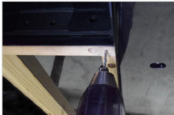
5. Faites à nouveau pivoter le renfort de support de pied et les composants attachés vers le haut et alignez le trou du support de montage du support de pied avec l'avant-trou que vous avez percé.
